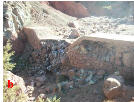
Figure 6 . a. Seuil en gabions non endommagé ; b. Seuil en gabions moyennement endommagé
