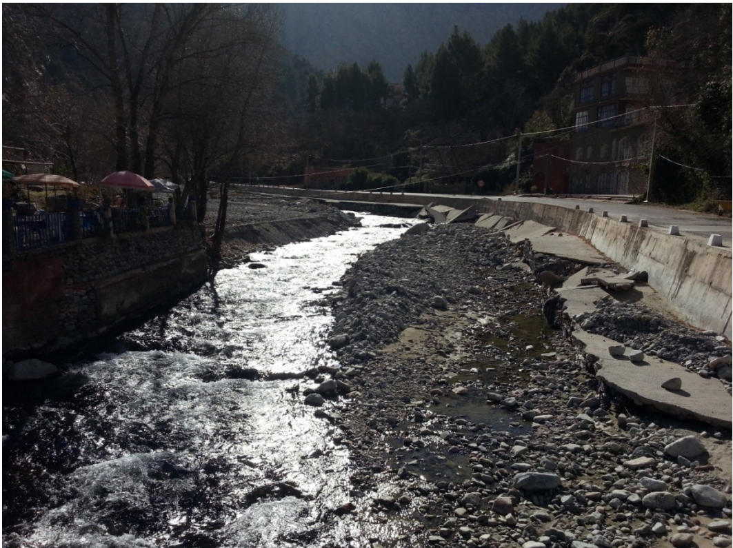
Figure 32 : Illustration des dégâts causés par les crues de l'Ourika (Segment 1 /Tronçon 2) AFFO, 2015
