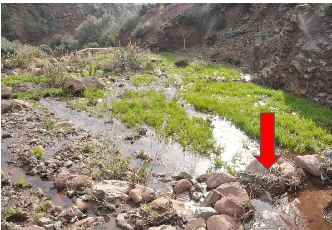
Annexe 6 : Barrière constituées de blocs disposés perpendiculairement au sens de l'écoulement de la seguia alimentant les terrasses
