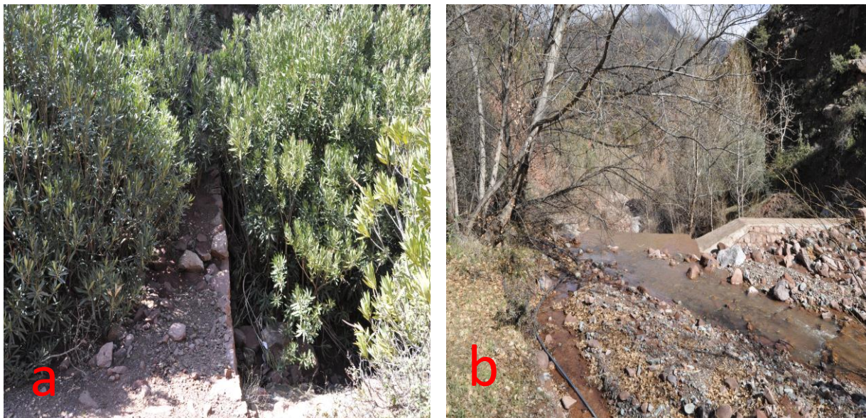
Photo 3 : végétalisation des ravins après les travaux de correction torrentielle ; a : lit mineur d'un affluent de l'oued Anins occupé par le laurier rose ; b : une partie du déversoir d'un seuil en maçonnerie de Tighzritze bloquée par le peuplier.
