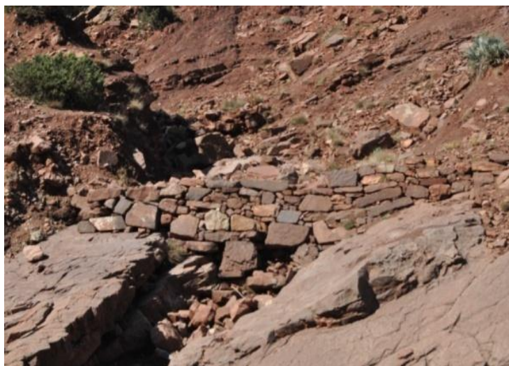
Photo 7 : Seuil en pierre sèche toujours fonctionnel, écoulement de quelques pierres au niveau du déversoir
