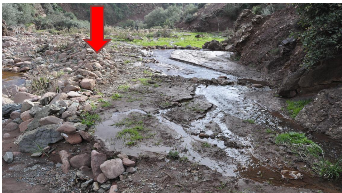
Annexe 4: Délimitation et fixation du bord d'une nouvelle terrasse par les pierres ramassées lors de l'aménagement des sédiments pour l'installation de la terrasse.
