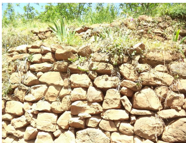
Murette de terrasse a Ignane
