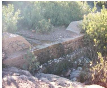
**Figure 18:** Végétalisation du seuil en maçonnerie par le *Pinus halepensis* à Imine El Ghar
