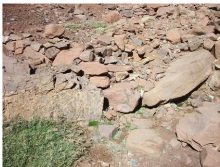
**Figure 26:** Seuil en pierres sèche construit par des roches amorphes à Chiker
