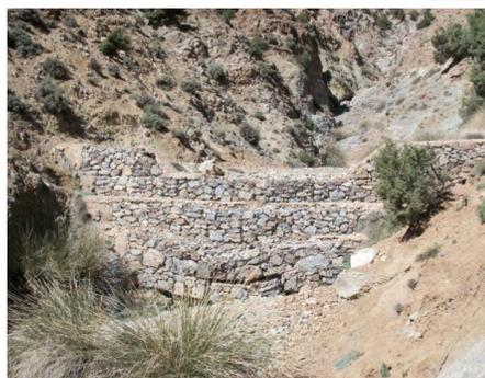
**Figure 12:** Végétalisation du seuil en gabion par des Poacées avec des PAM à Asgaouer
