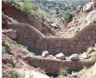
**Figure 7:** Mise en place de la végétations (Poacées) derrière de seuil en maçonnerie à Chiker
