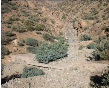
**Figure 8:** Mise en place de la végétations (*Adenocarpus anagyriifolius*) derrière de seuil en maçonnerie à Chiker
