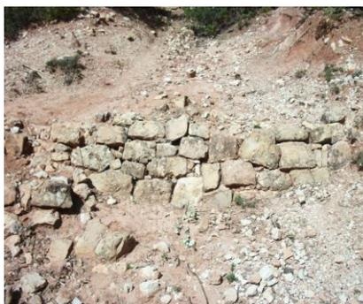
**Figure 25:** Seuil en pierre sèche construit par des roches sphériques à Okeïmden
