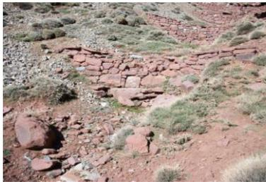
**Figure 10:** Mise en place de la végétations (Xérophytes épineux) derrière de seuil en maçonnerie à Chiker
