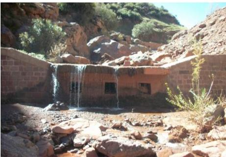
**Figure 20:** Blocs de grande taille derrière un seuil en maçonnerie à Oulmes
