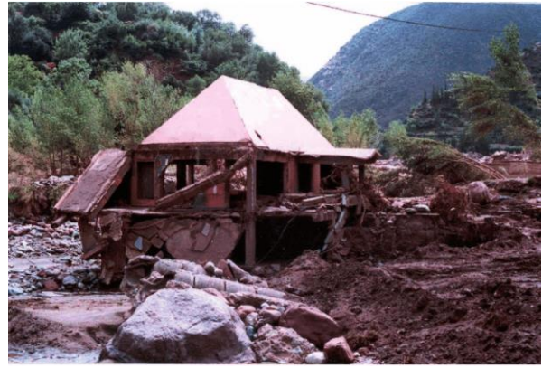
Figure 13 : Exemple de dégâts de la crue du 17 août 1995 et du niveau atteint par ses dépôts (Source : agence de bassin hydraulique de Tensift).
