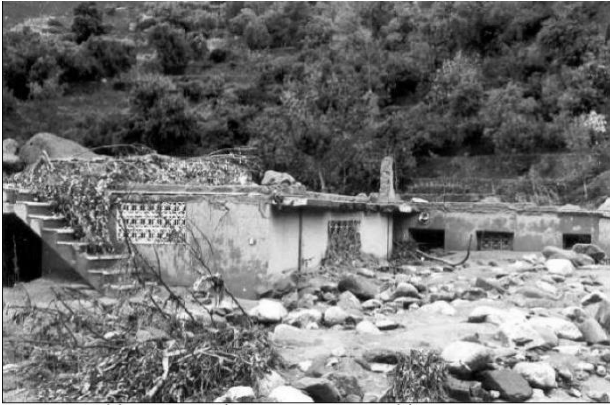
Figure 13 : Exemple de dégâts de la crue du 17 août 1995 et du niveau atteint par ses dépôts (Source : agence de bassin hydraulique de Tensift).
